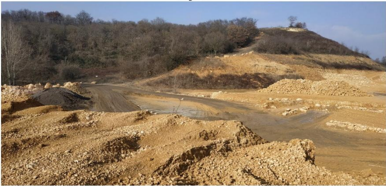
Foto 3. Panoramica del cantiere: In primo piano il piazzale di cava (q. 176 m slm circa), in secondo piano il Monte del Prete con il fronte provvisoriamente rimodellato e rivegetato
