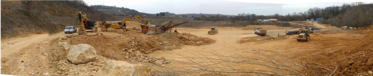
Foto 2. Panoramica del cantiere nel settore nord orientale. In primo piano i piazzali in coltivazione, in secondo piano il fronte rimodellato ed in fase di ripristino
